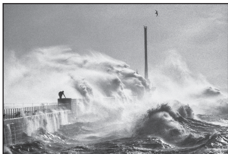
La digue Nord, Le Havre, 1984
