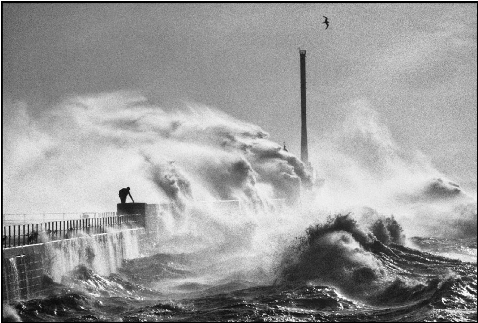
La digue Nord, Le Havre, 1984
