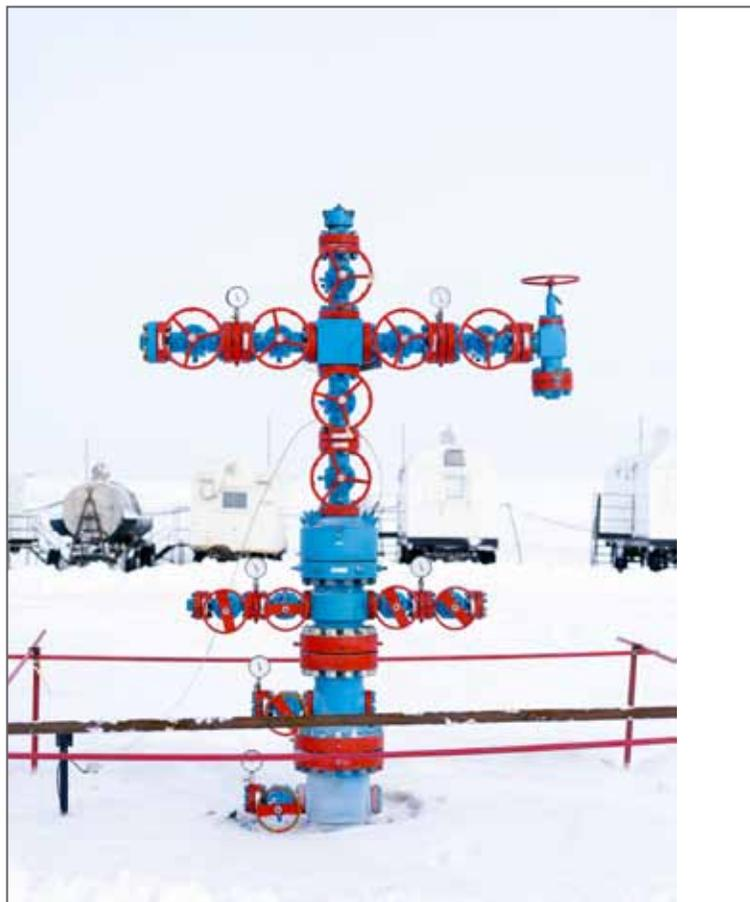
Valves à la sortie d'un puits de gaz qui seront bientôt reliées au réseau de pipeline.
