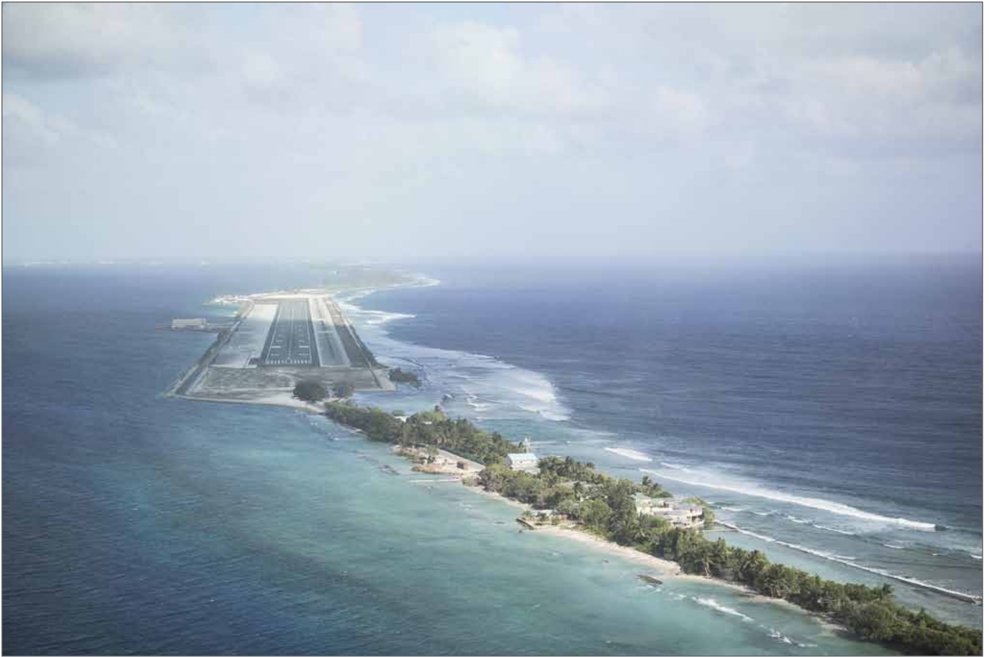
Aéroport international, atoll de Majuro, République des îles Marshall. Majuro International Airport, Majuro Atoll, Republic of the Marshall Islands.
